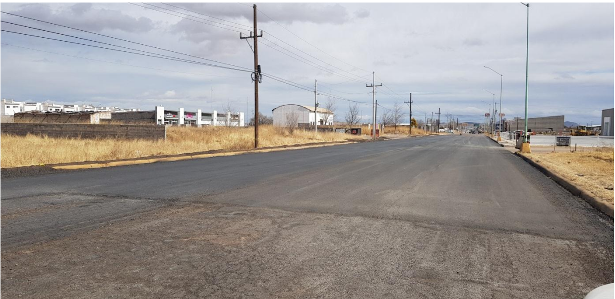
Ⓢ Parte del material producto de la escarificación a los lados de la vialidad.
