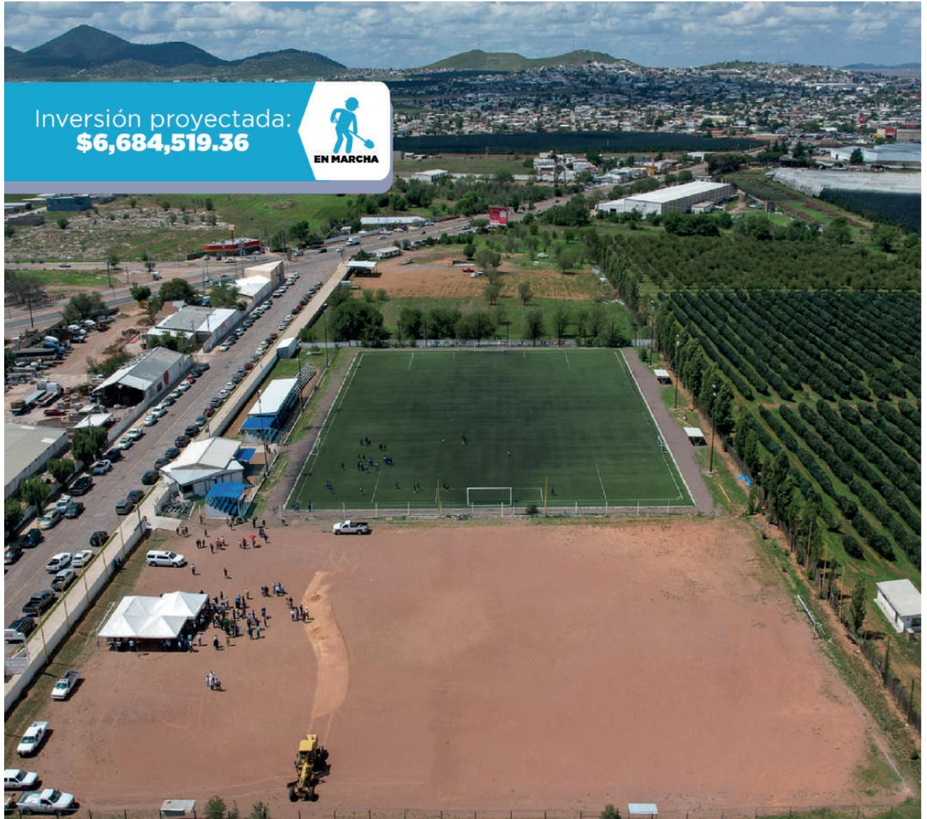
La construcción de la cancha se realiza en una superficie de 7070 metros cuadrados, donde se pondrá una base hidráulica de 2121 metros cúbicos y 6800 metros cuadrados de pasto sintético de 45 milímetros. Además, se colocarán 2 porterías profesionales.
