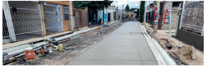
\* **Rehabilitación a base de fresado y sobrecarpeta asfáltica en calle Eucalipto, entre Tepozanes y Táscales**
