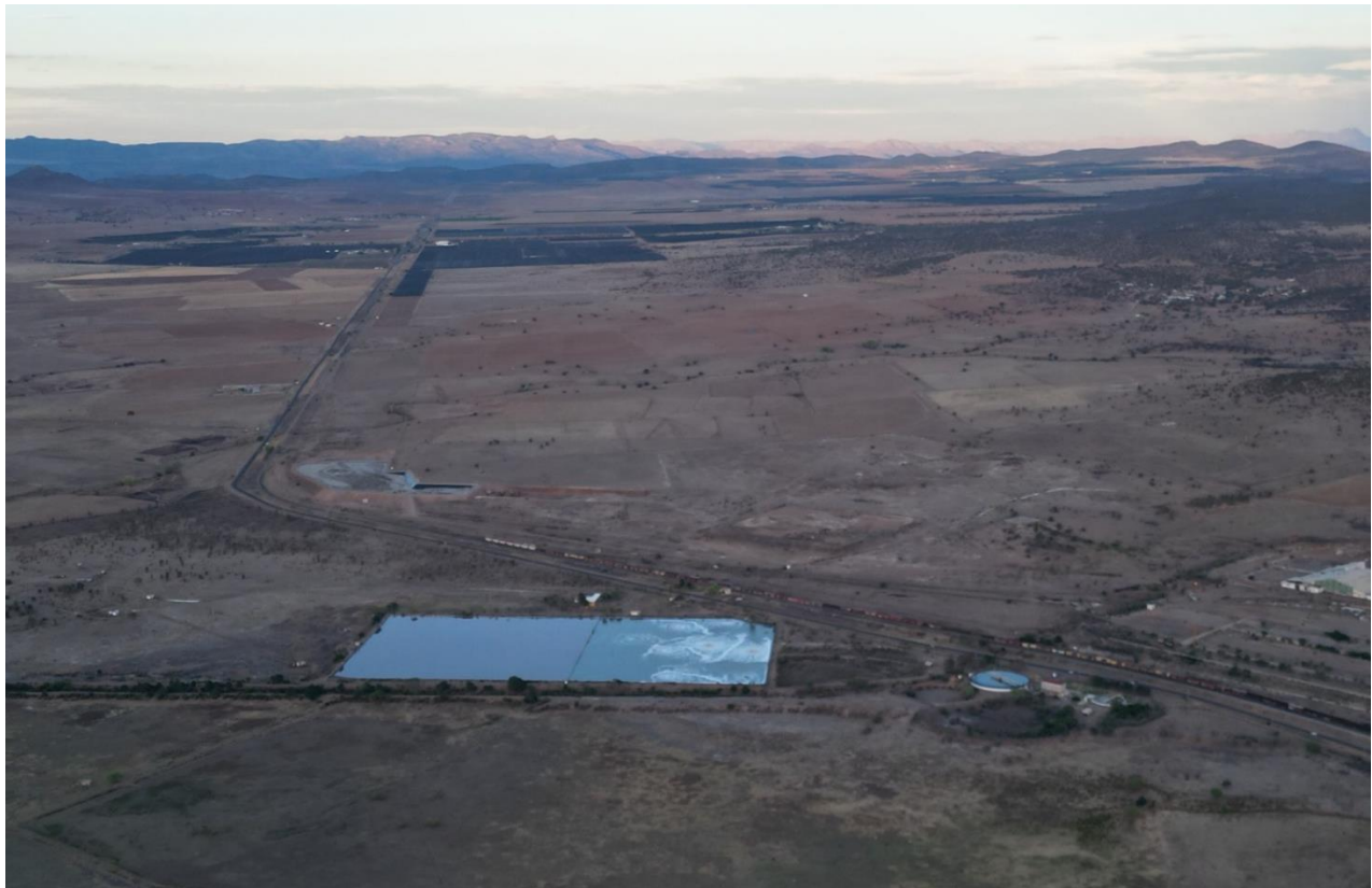
Ilustración 15. Actual Planta de Tratamiento de Aguas Residuales cercana a la Col. Anáhuac
