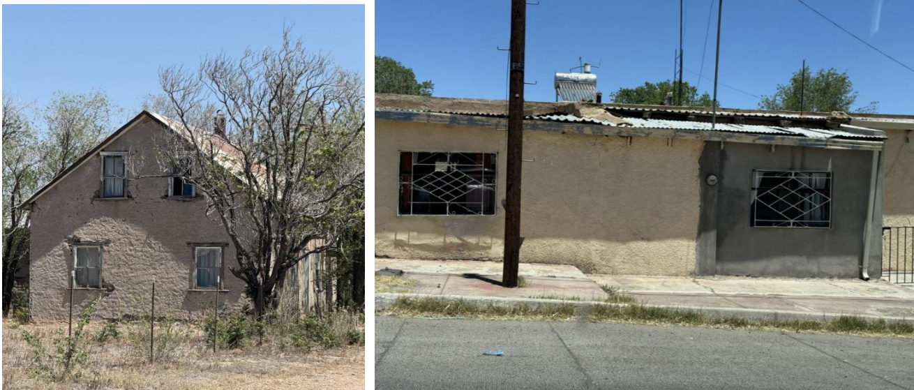
Imagen 10. Viviendas sin condiciones de habitabilidad
