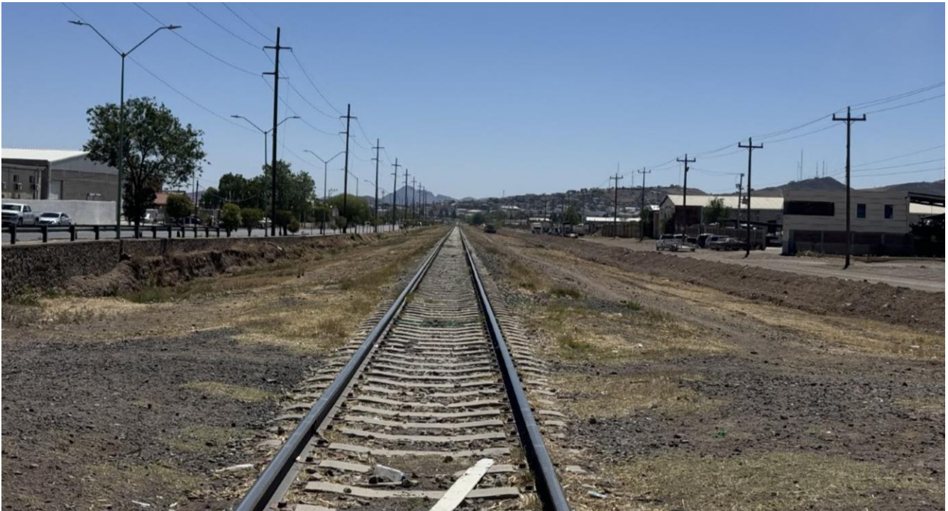
Imagen 4. Tramo de la vía férrea que limita el paso vehicular y peatonal
