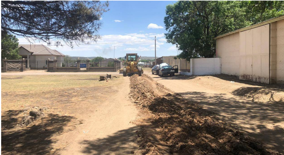
Ampliación de red general de agua potable en Ejido Napavechi
