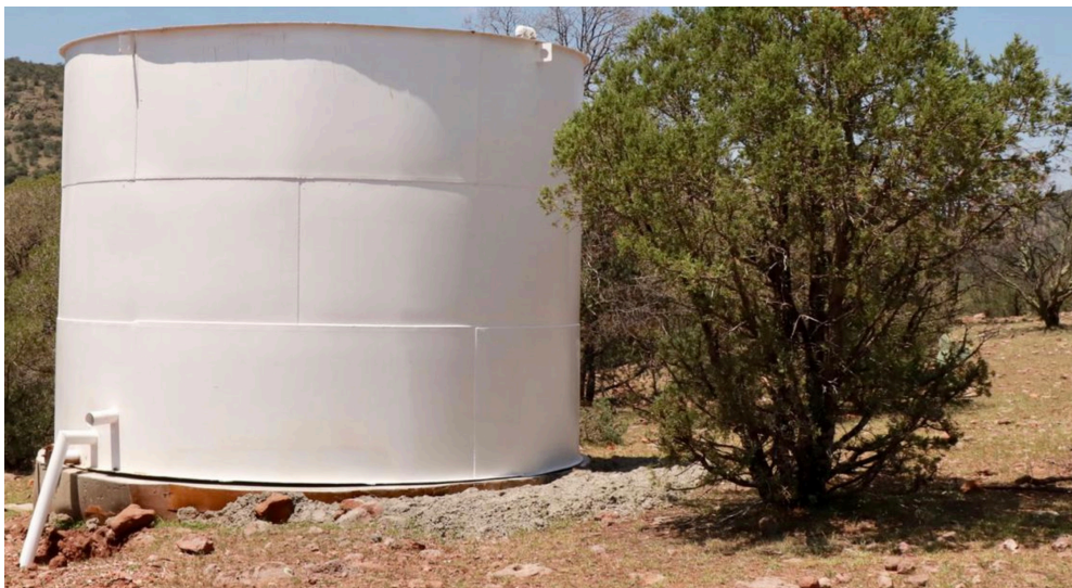
Construcción de tanque de almacenamiento de agua en Ejido Nuevo Zaragoza
