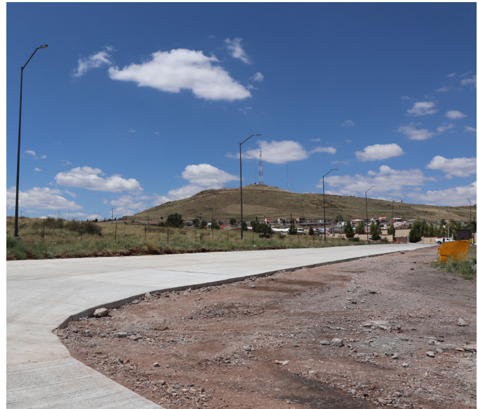
Pavimentación de la calle de acceso al CBTa. 90
