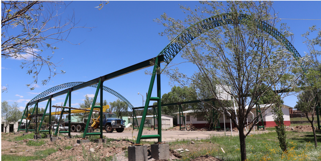
Construcción de domo en Secundaria No. 6047
