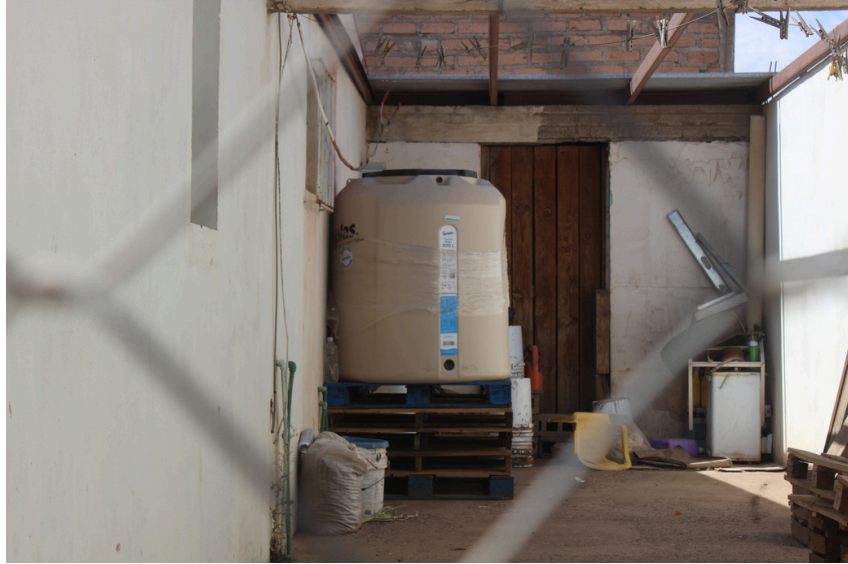
Tinaco sin instalación
